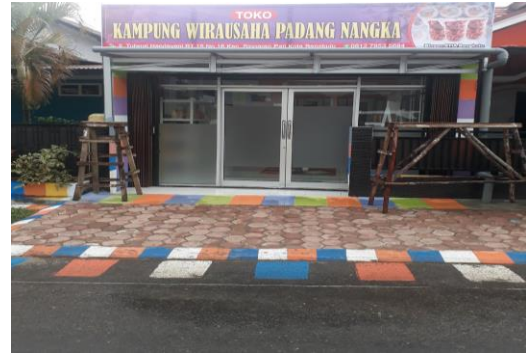
Gambar 8. Proses pembuatan outlet , gapura dan taman sepanjang jalan kampung wirausaha
