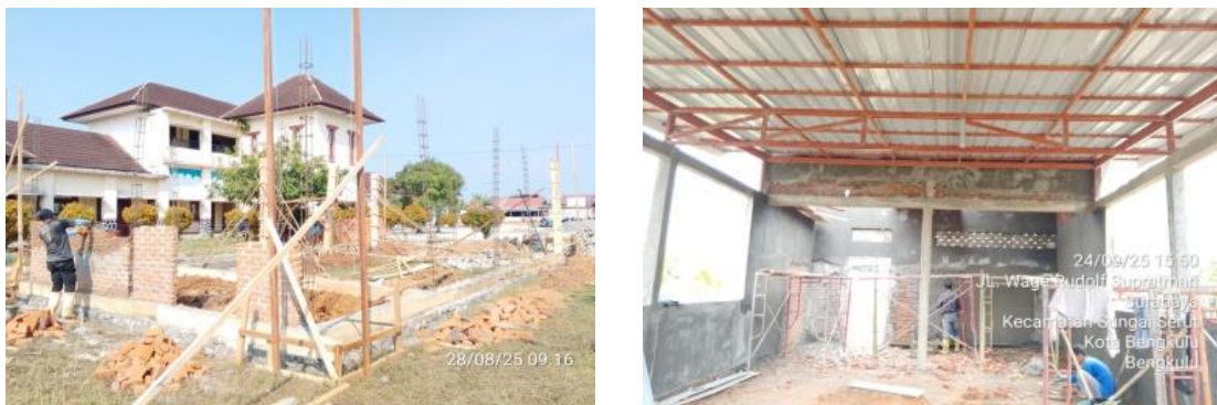
Gambar 3. Pekerjaan pemasangan dinding serta plesteran dan acian (Sumber: inspector proyek, Kel. Surabaya Kota Bengkulu, 2025)
