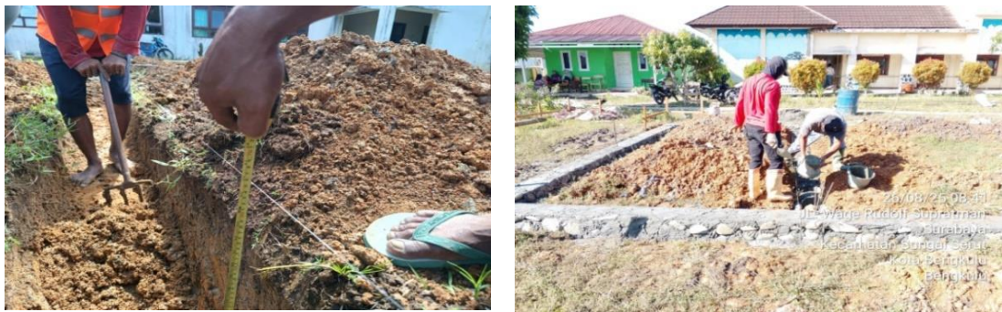
Gambar 1. Proses penggalian dan instalasi tulangan pondasi (Sumber: inspector proyek, Kel. Surabaya Kota Bengkulu, 2025 )
