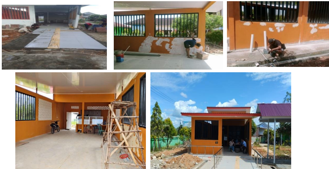
Gambar 5. Kondisi akhir bangunan kantin setelah tahap finishing (Sumber: inspektor proyek, Kel. Surabaya Kota Bengkulu, 2025)
