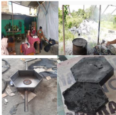
Gambar 6. Sosialisasi Pembuatan Paving Blok
